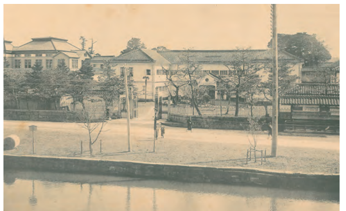
福井県庁〔現西武福井店付近〕（明治42年）
