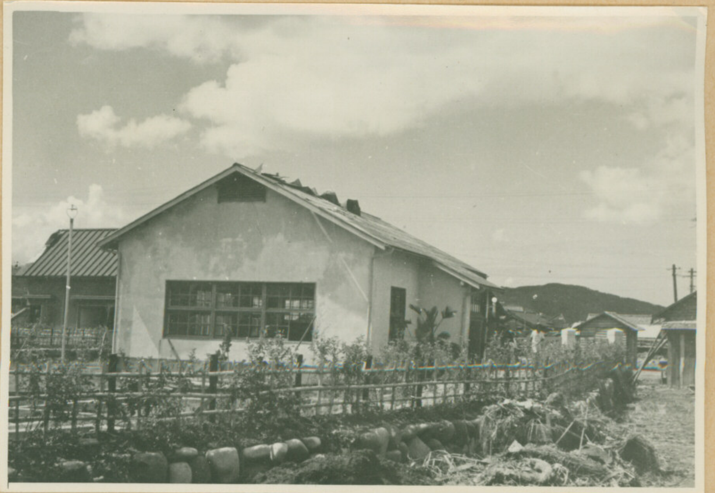
A5-51-143 足羽ポンプ場
