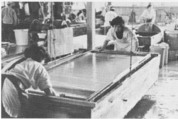
⑱ たてた紙の素を、桁に竪をはめたもので掬い上げ、前後にゆすると水が濾過して繊維がからみ合う。紙の厚薄を見計い、最後に掬ったうわ水を流し捨てる。これを流流 （ながし） という。
