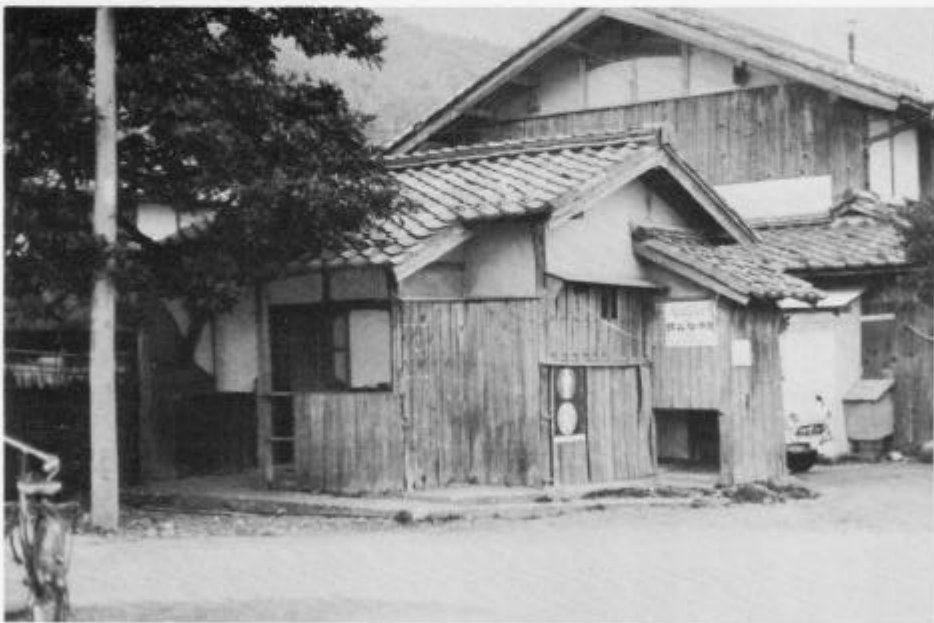
産小屋外観（敦賀半島 常宮）
