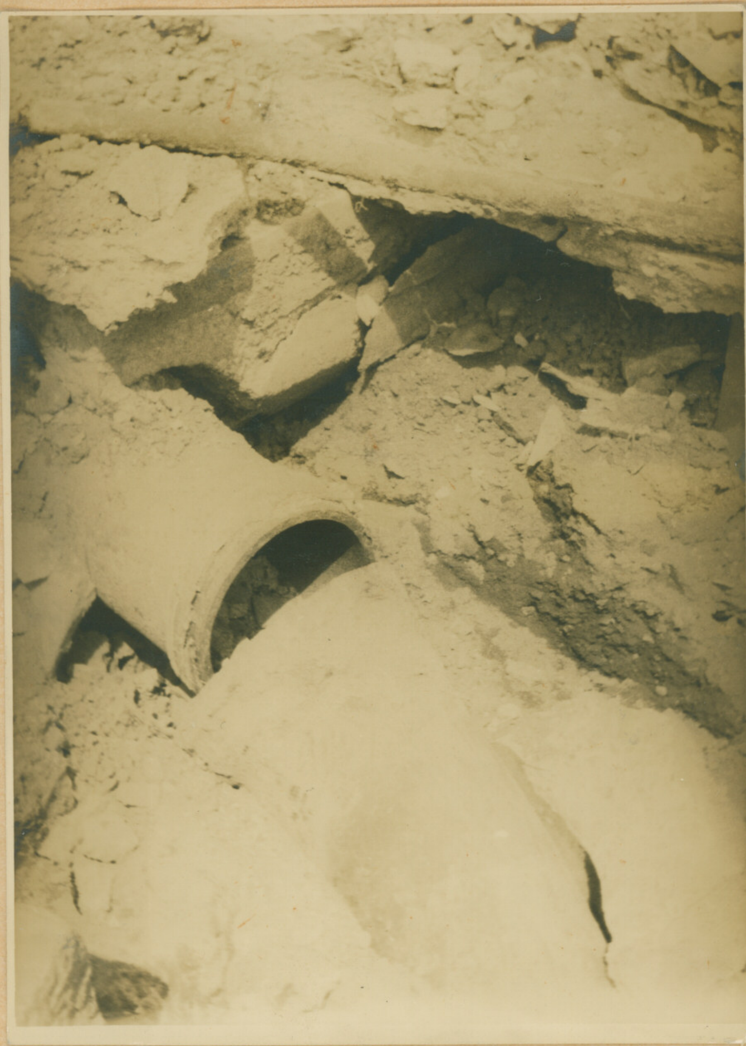
✓ 幸橋上流南詰
