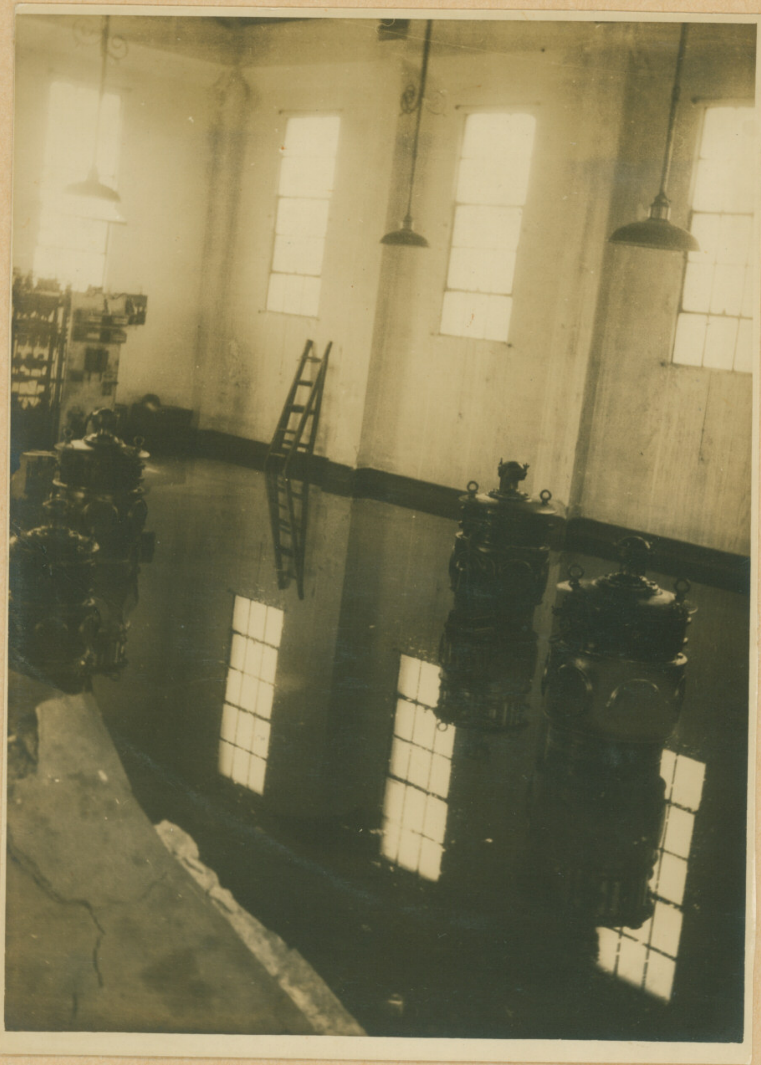
No. 9 水源ポンプ場
