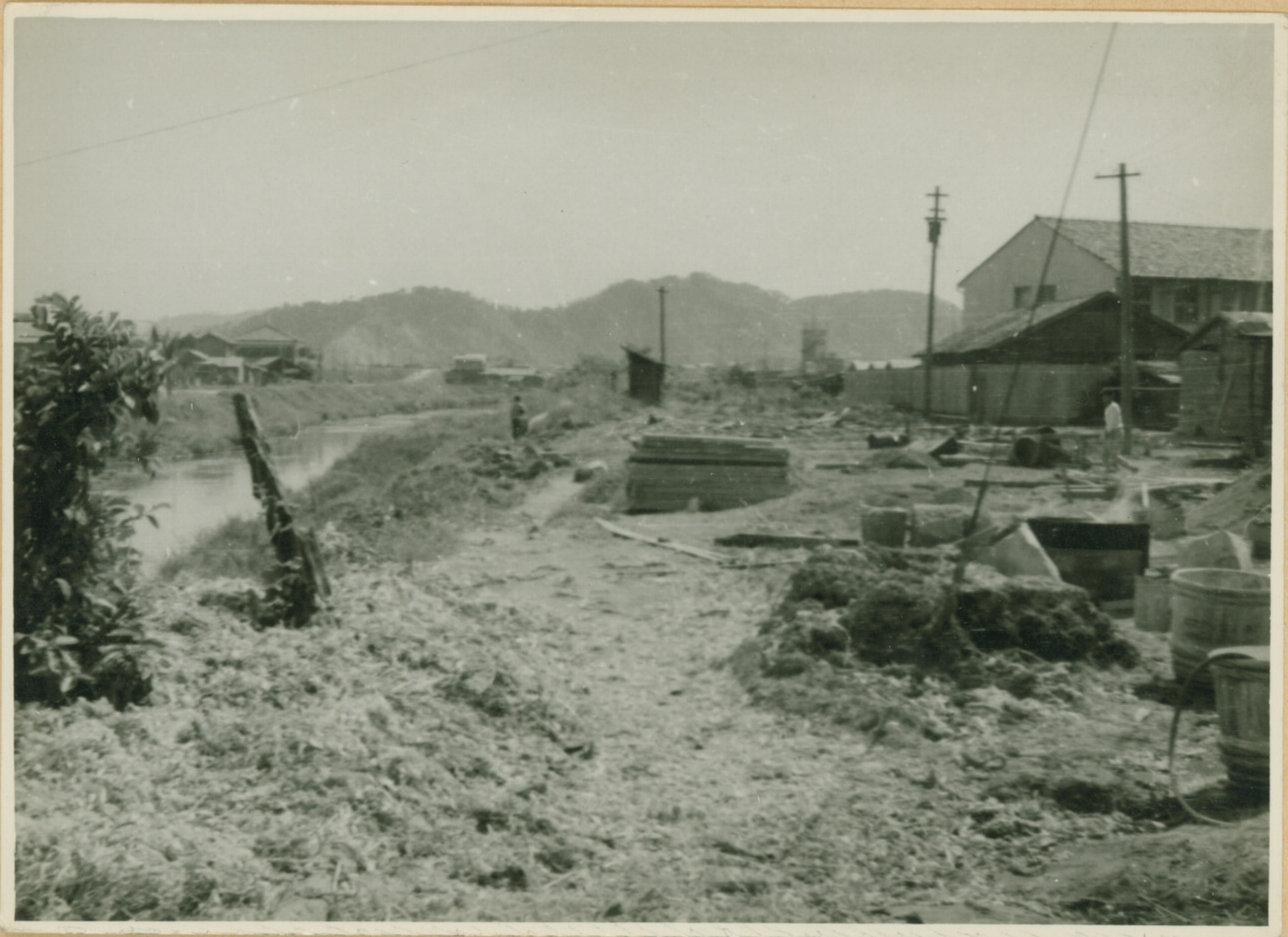
A23-10-18 電気通信部付近
