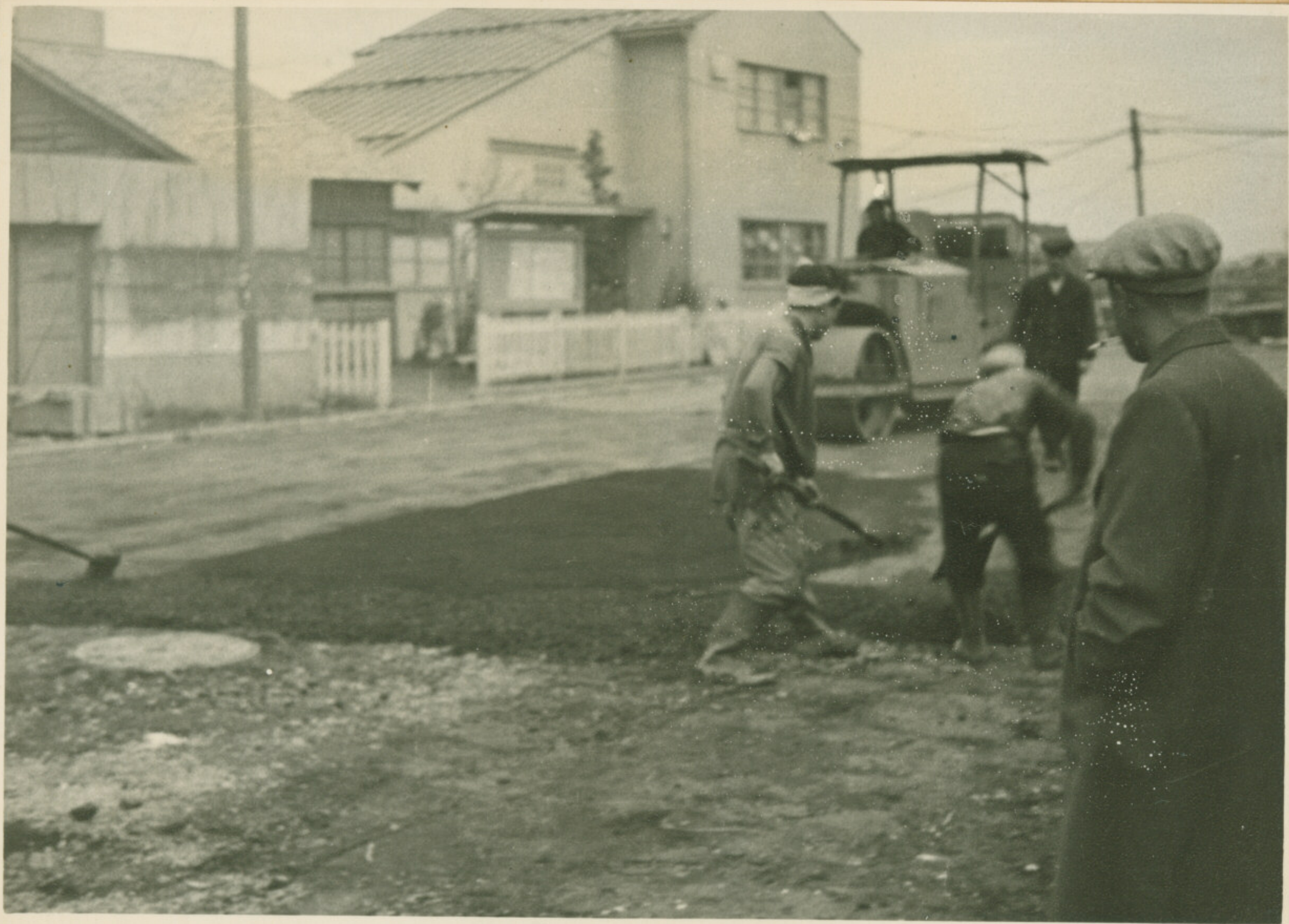
市役所附近 道路工事 A22-15-26
