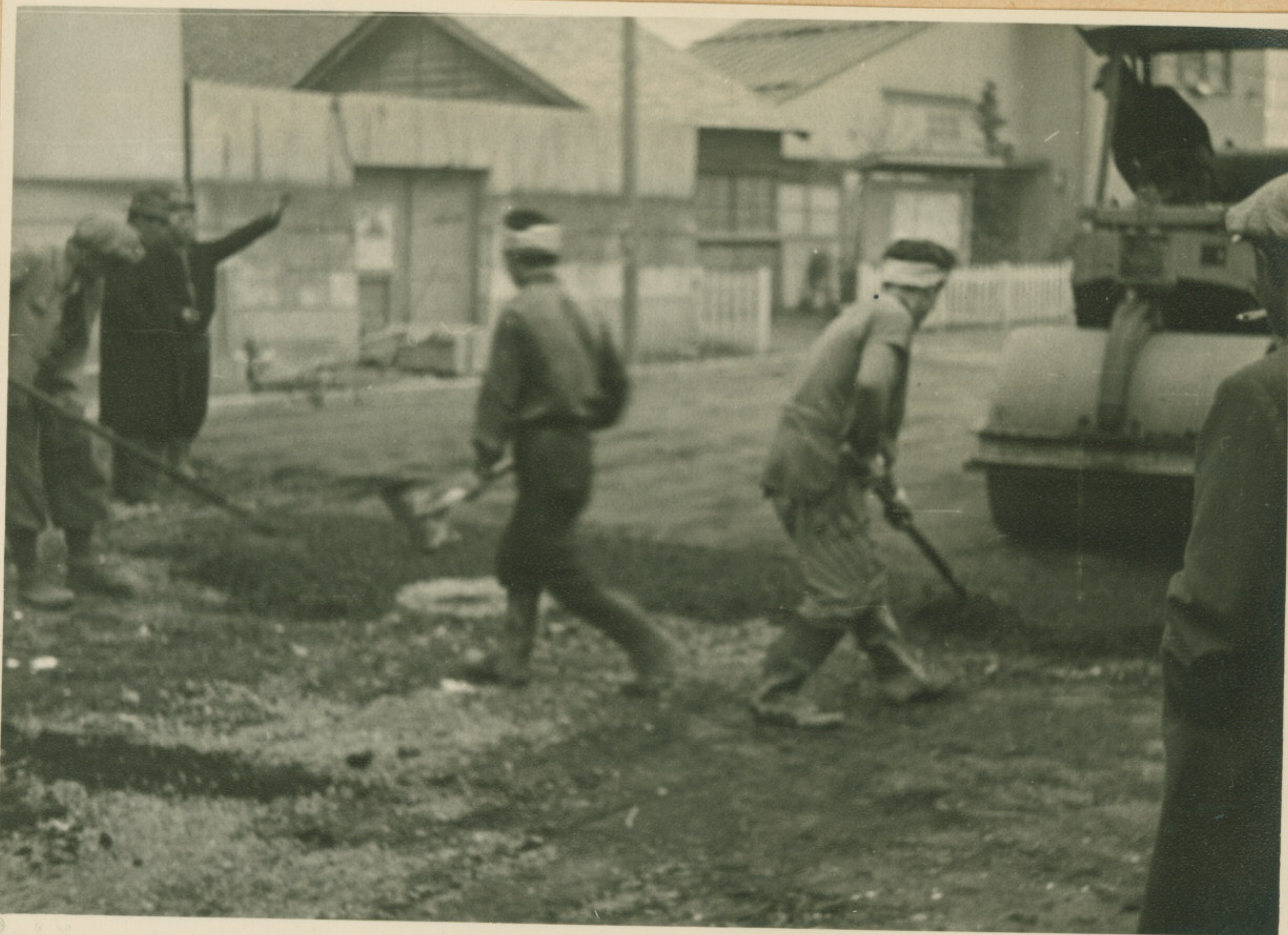
市役所附近 道路工事
