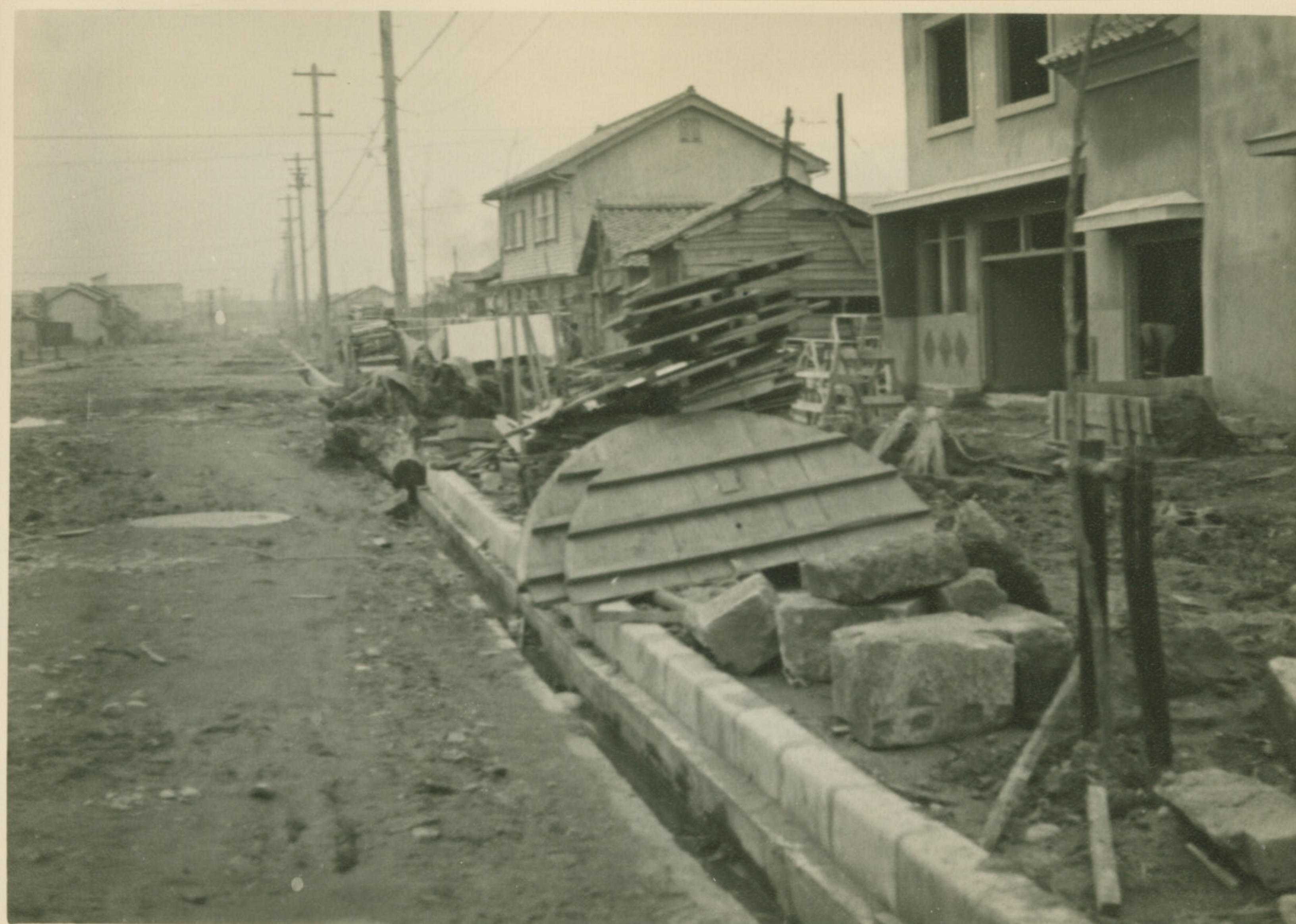
市役所附近道路工事
