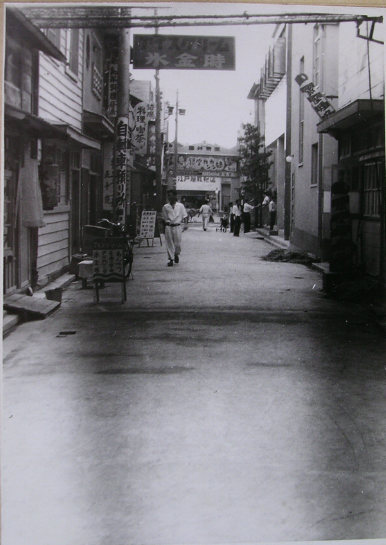
メトロ会館横通り
