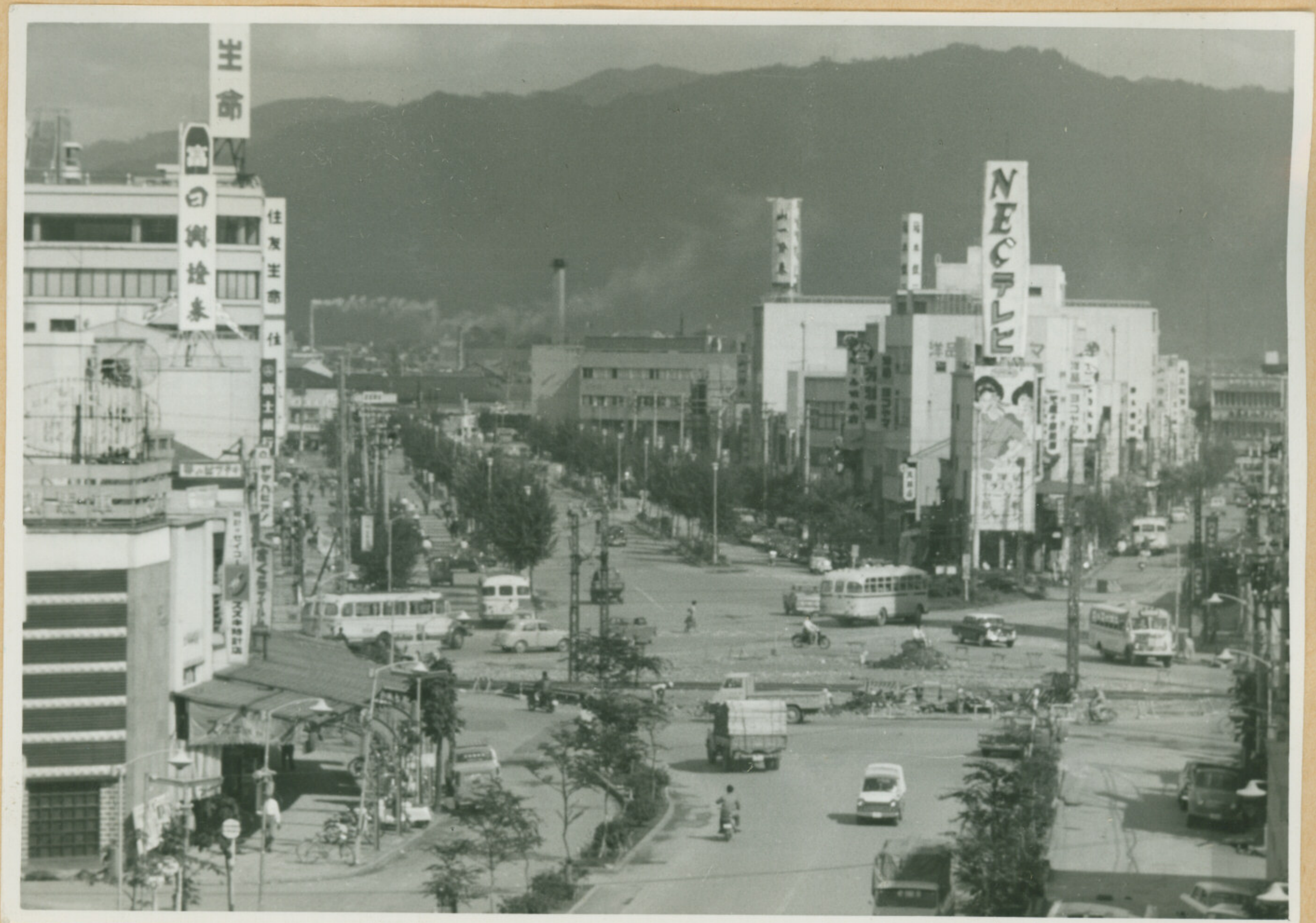
ロータリーの撤去工事 A17-46-110
