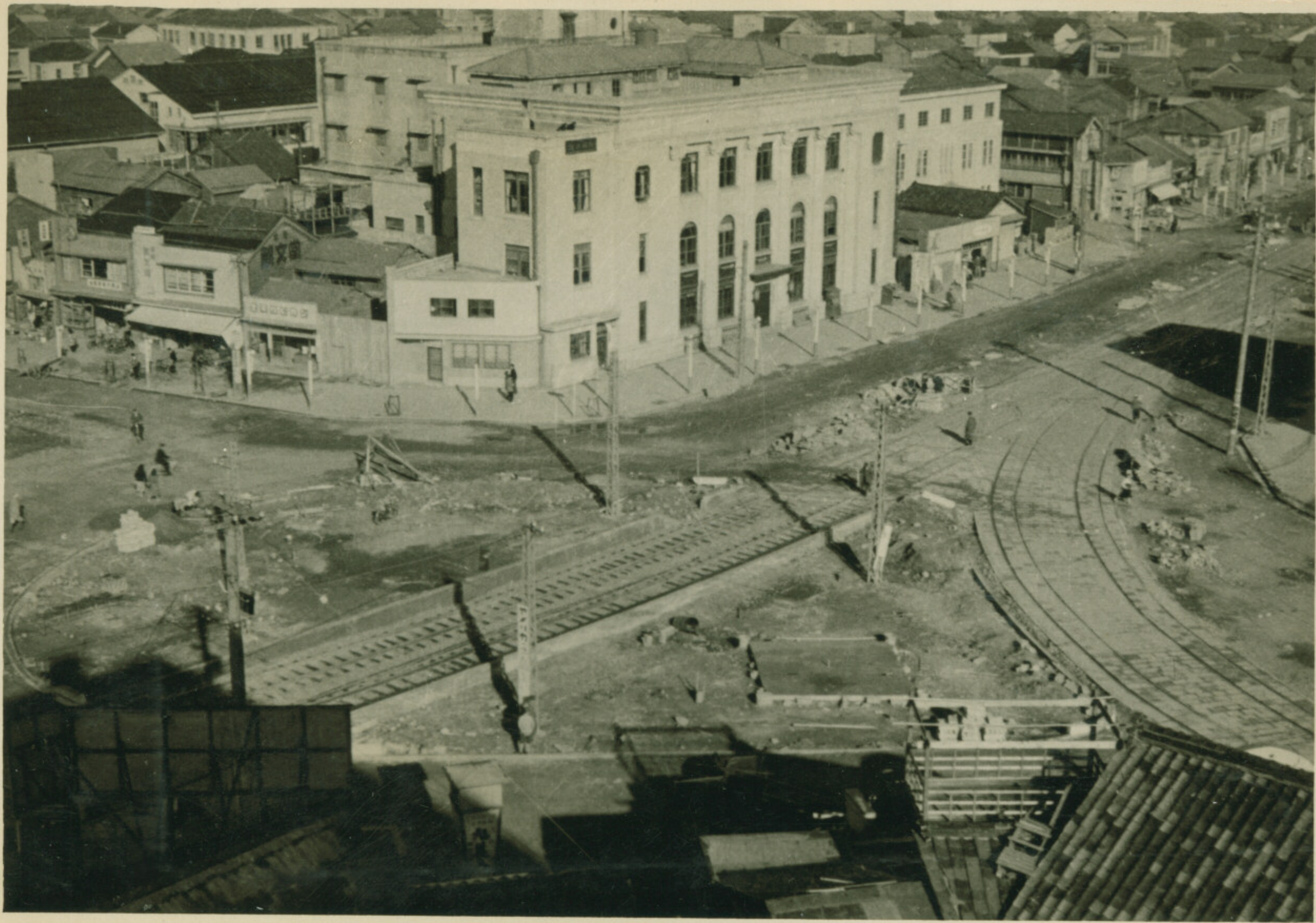
ロータリーの造成工事 A17-55-129
