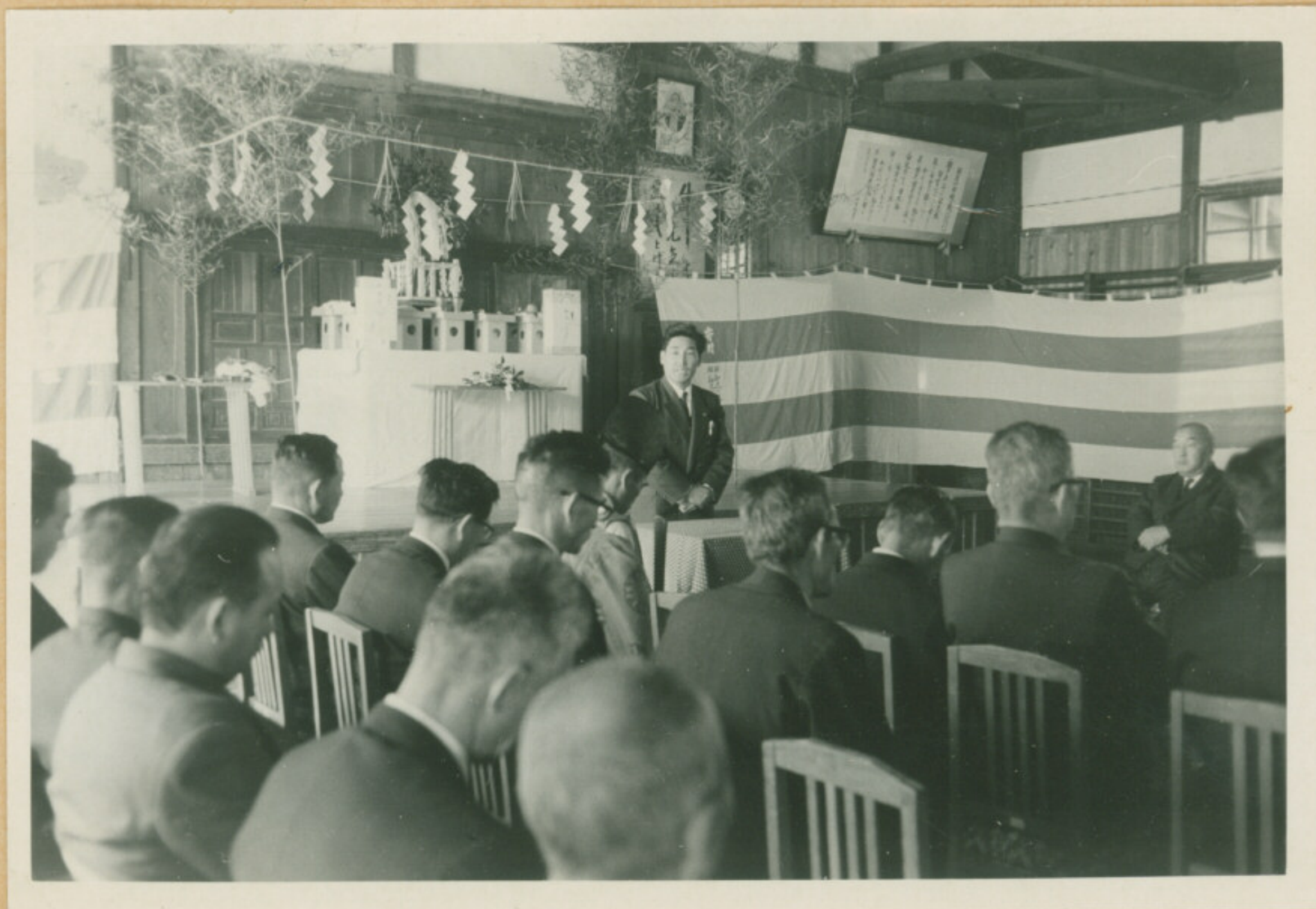
新川橋場水道完成 (1941.12) A16-34-98
