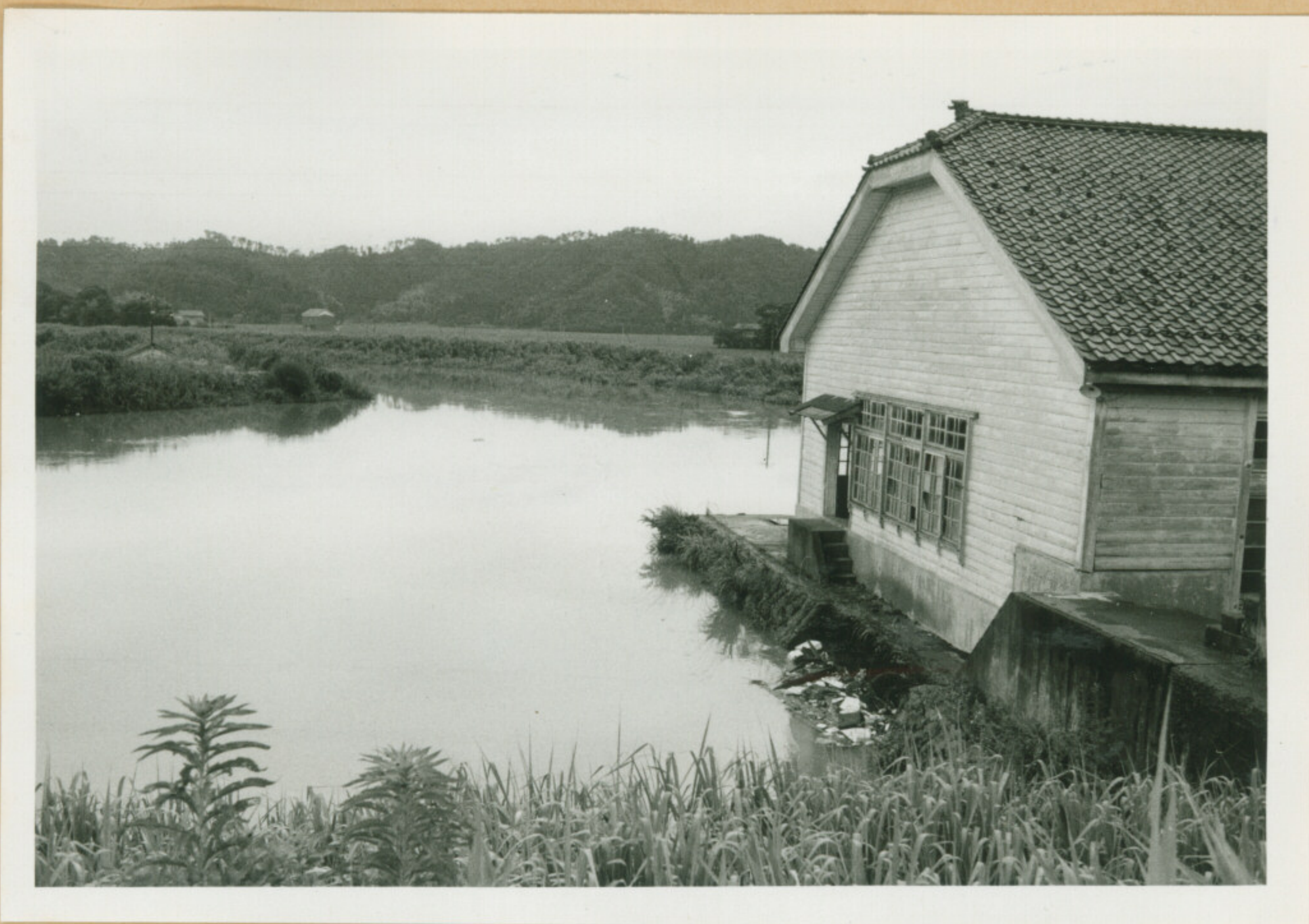
江端川ポンプ場
