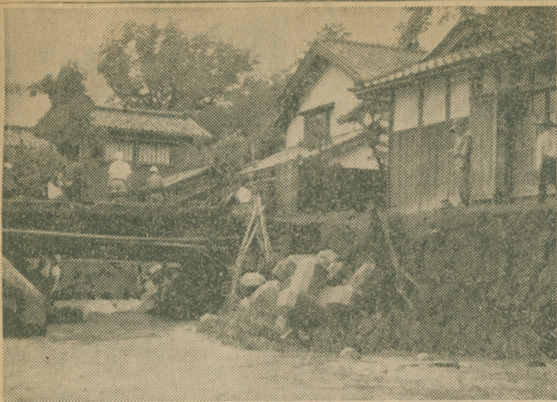
鉄砲水で堤防が決壊、危険になった民家（南条郡南条町脇本で）
