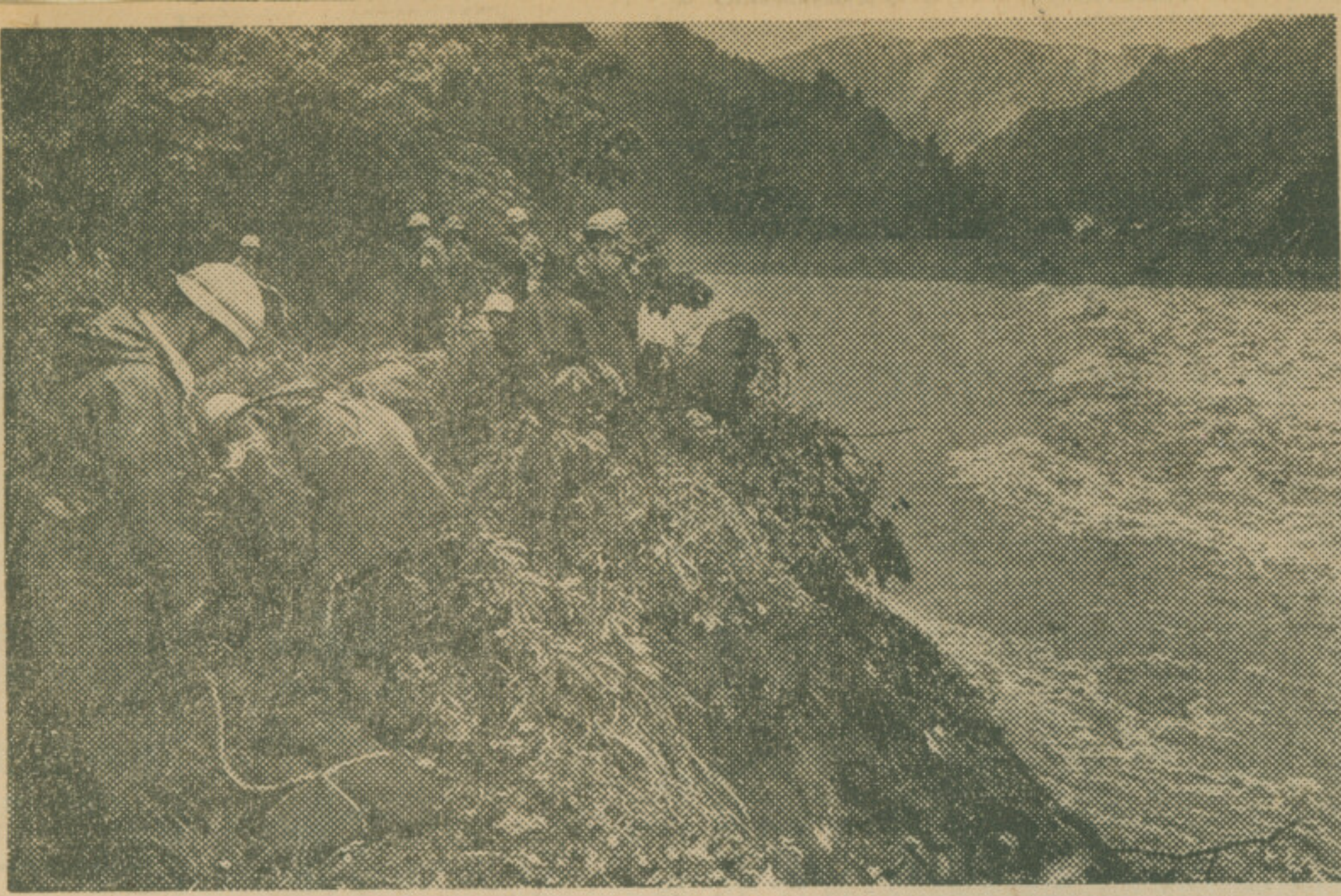
足羽川堤防の補強工事に繰り出した美山町消防団員ら。美山町蔵作地籍で
