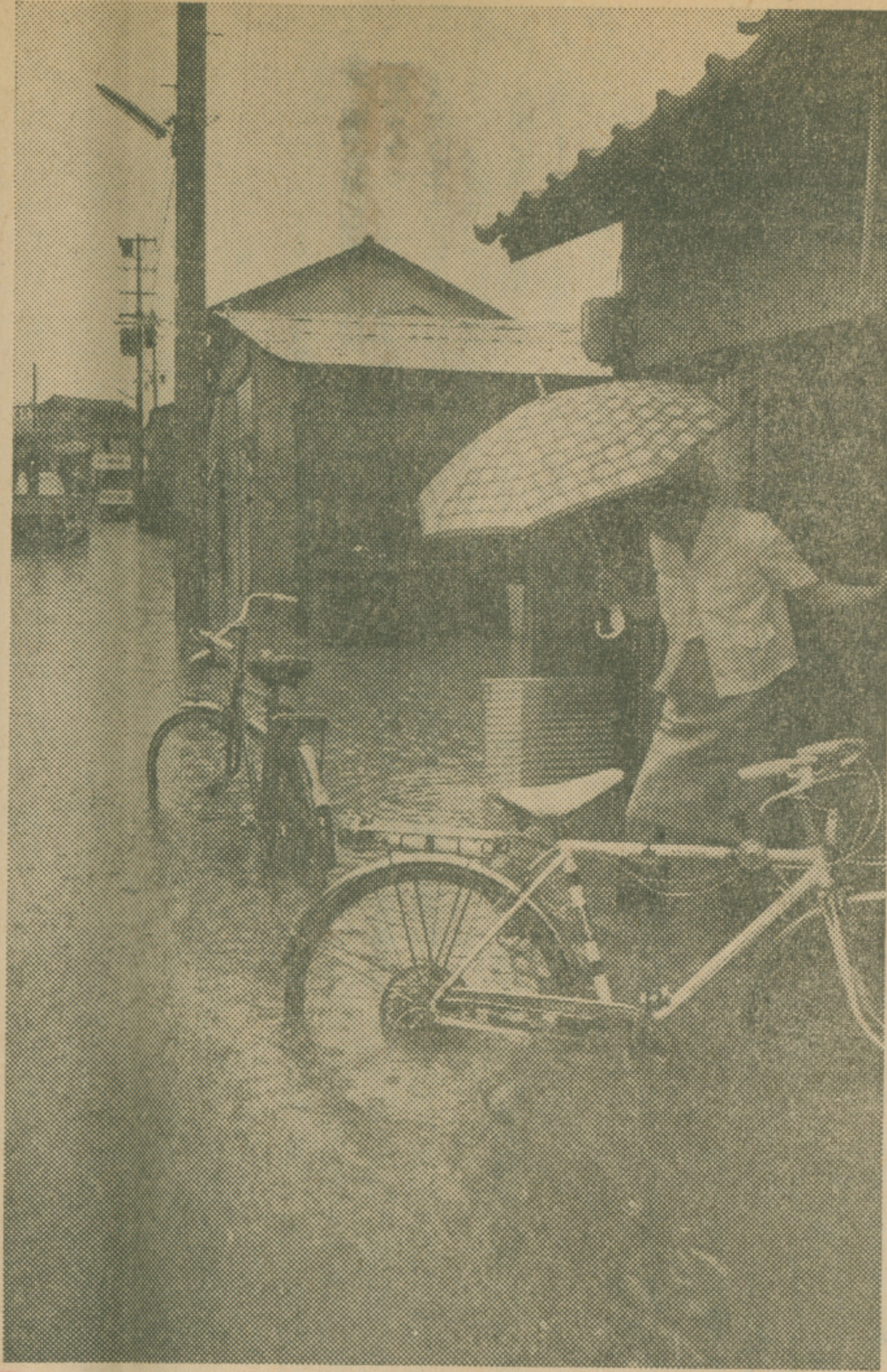
床上浸水した福井市日之出四丁目付近の住宅
