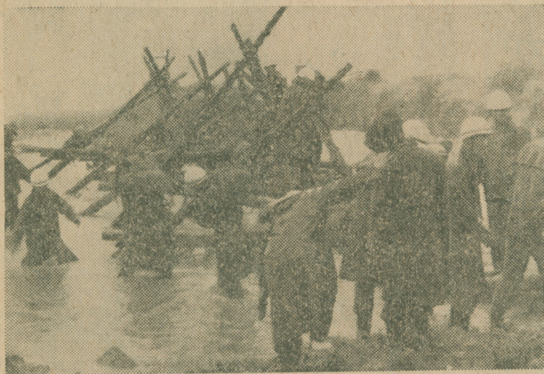
やぐらを組んで決壊した鞍谷川の応急補修をする水防団員（武生市池泉町で、12日午前10時30分）
