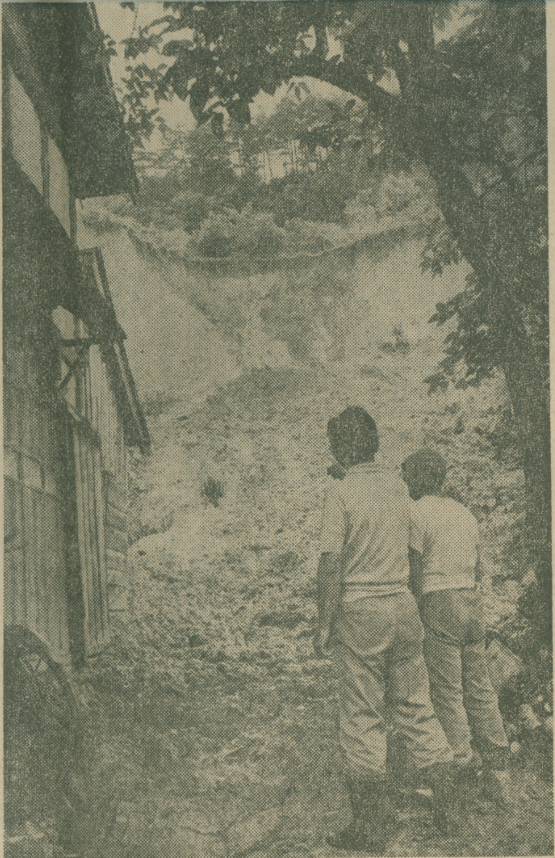
裏山がくずれ落ち危陰にさらされている小坂さん方住宅Ⅱ福井市金屋町で
