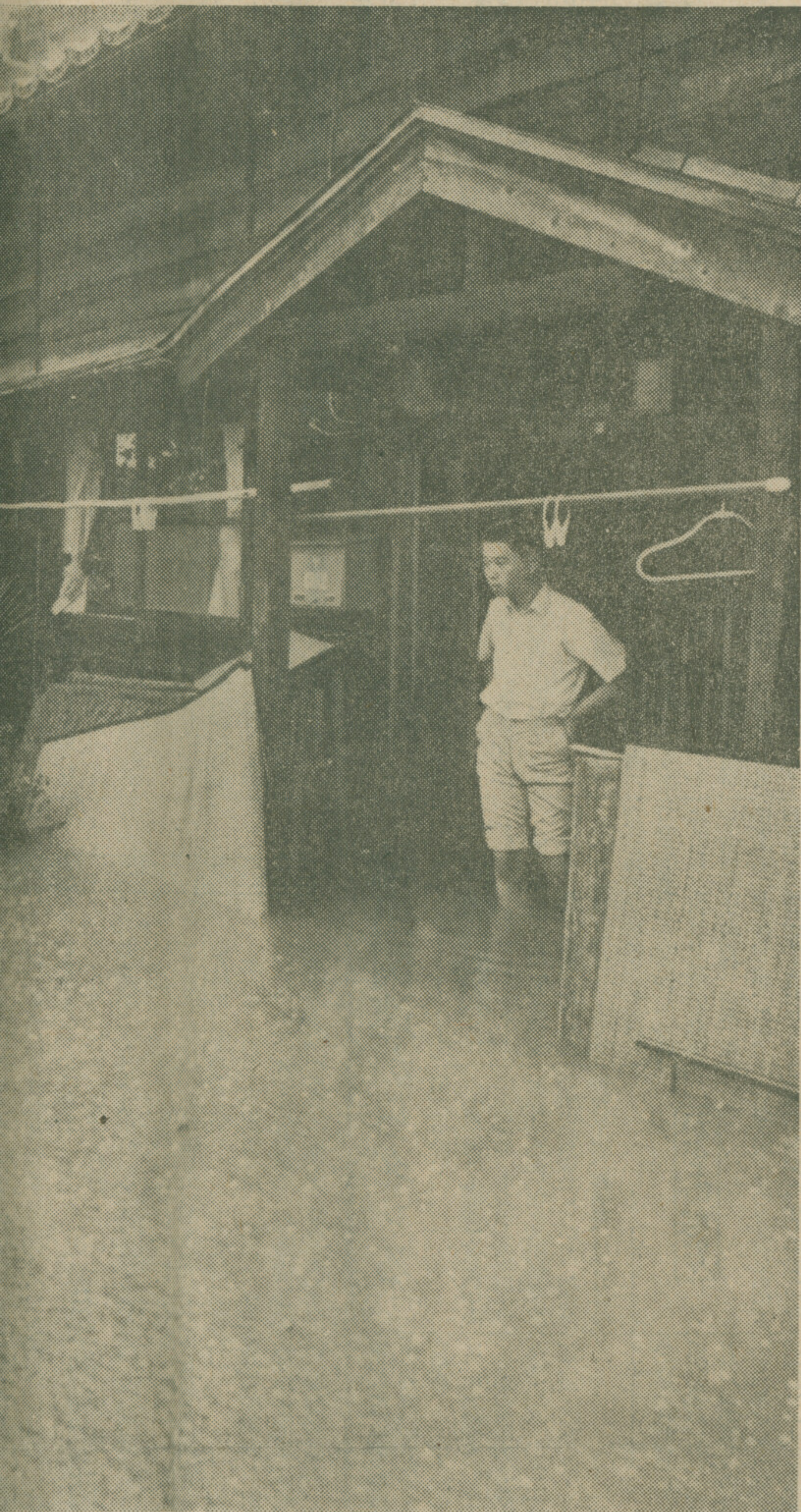
大雨で、付近の小川がはんらんして床上浸水した日之出四丁目
