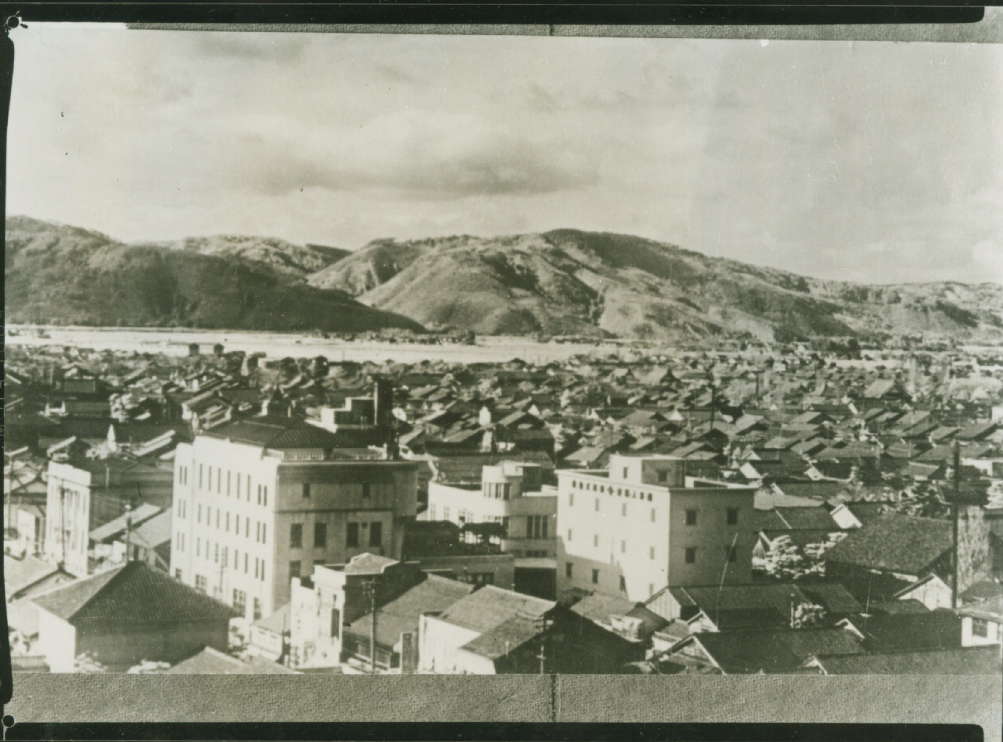
NO. 2 大和ビルからの市街地(西方)
