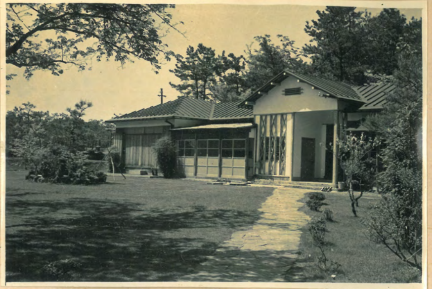
足羽山配水池事務所
