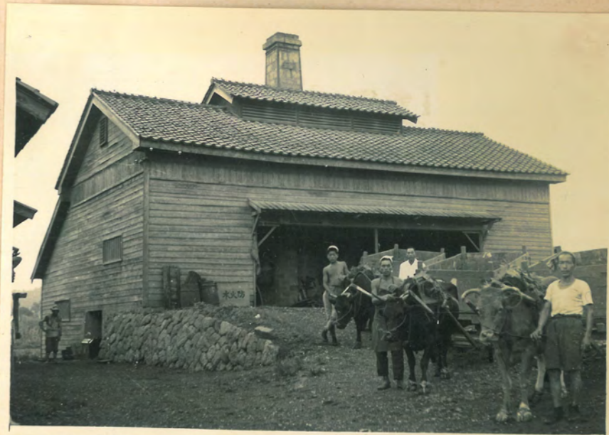
明里塵芥焼却場
